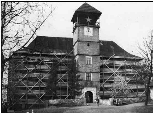
Rekonstrukce v 50. letech 20. stol. (Foto SOKA F-M).
