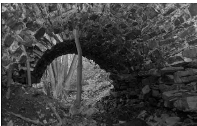
Průhled bývalým mostkem (Foto Adam Bill).
