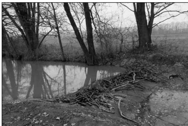
Rozšířené místo, nově vytvořenou tůň, využili bobři a přelivnou hranu si předělali po svém. Foto během realizace, 27. listopadu 2018, archiv obce Proskovice.
