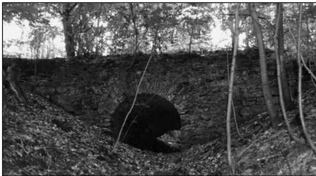
5 Klenutý mostek na staré cestě k zámku.
