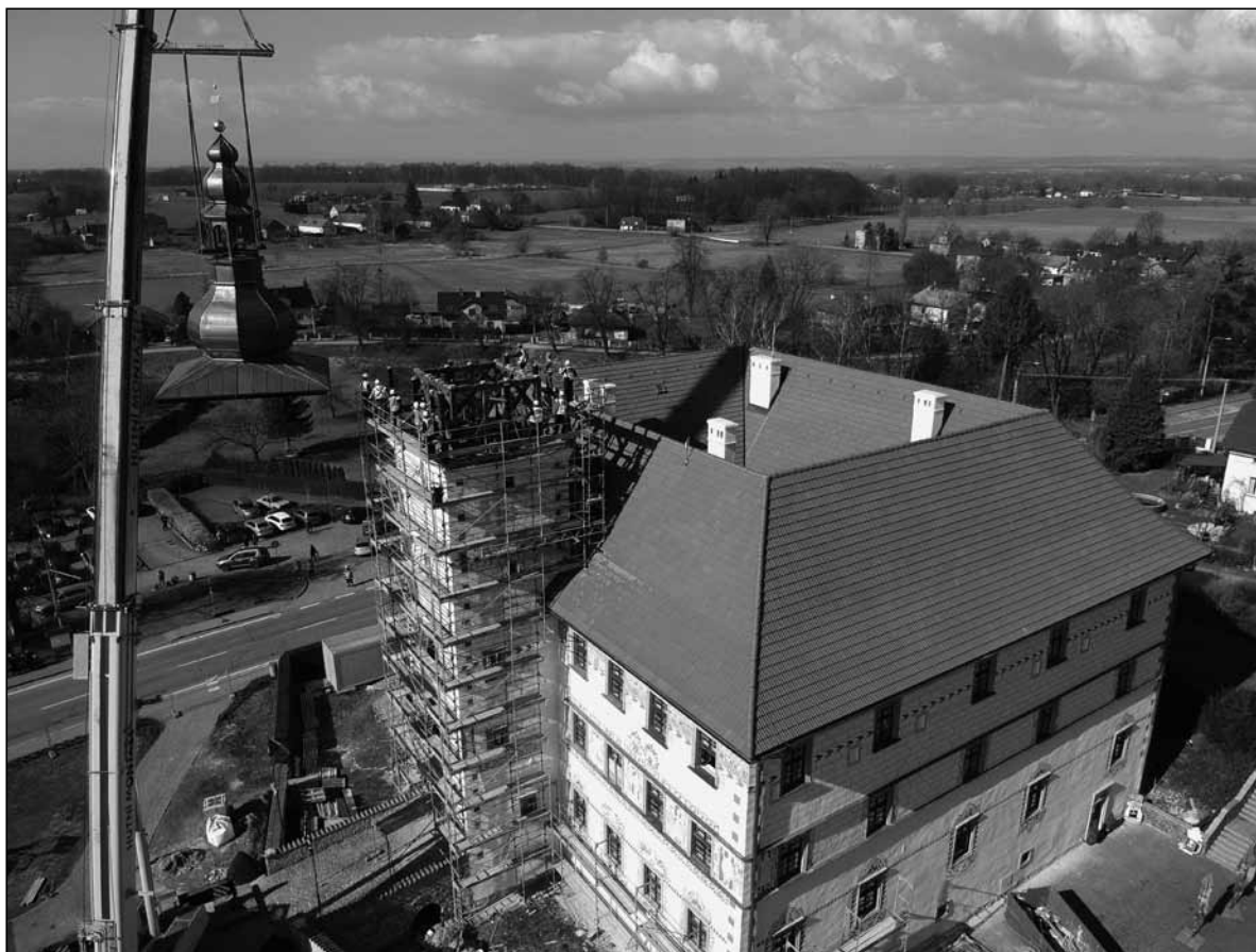
Instalace věžní bání (Foto Filip Dekleva).
